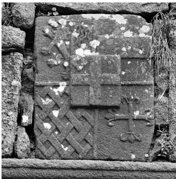
Tréfalegan, élévation nord : pierre armoriée au-dessus de la porte (état en 1986).
